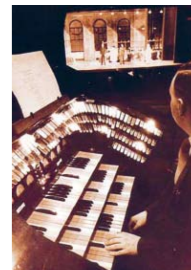
Fred Bentham nel 1935 pilota una Strand Light Console, uno dei più riusciti esperimenti pionieri del controllo luci. Un organo da chiesa modificato permetteva per la prima volta ad un operatore in sala di controllare macchinari complessi come i dimmer resistivi posizionati nei pressi del palco. I banchi di dimmer erano connessi ad aste manovrate da motori a velocità costante attraverso frizioni magnetiche.
