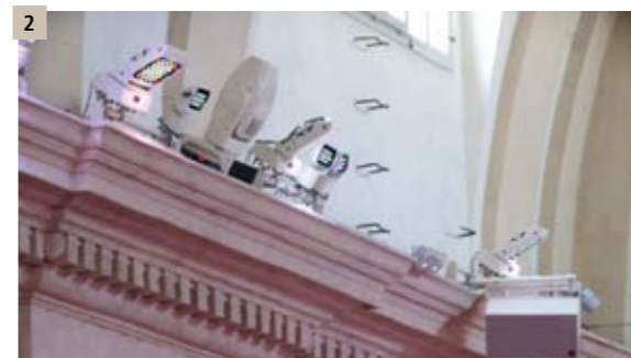
2: Vista dei dispositivi posti a metà sala, 11 m dal pavimento. Da sx: SGM Palco 5, Genio Mobile Giotto 400 Wash, Palco 5, 2 x Genio Mobile, Palco 5, d&b audio-technik Q7; tutti rigorosamente in versioni bianche.
