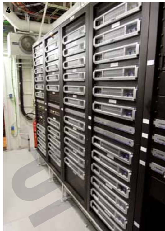
4_L'Amp Room, dove sono collocati gli amplificatori QSC per il Teatro Hortensia.
