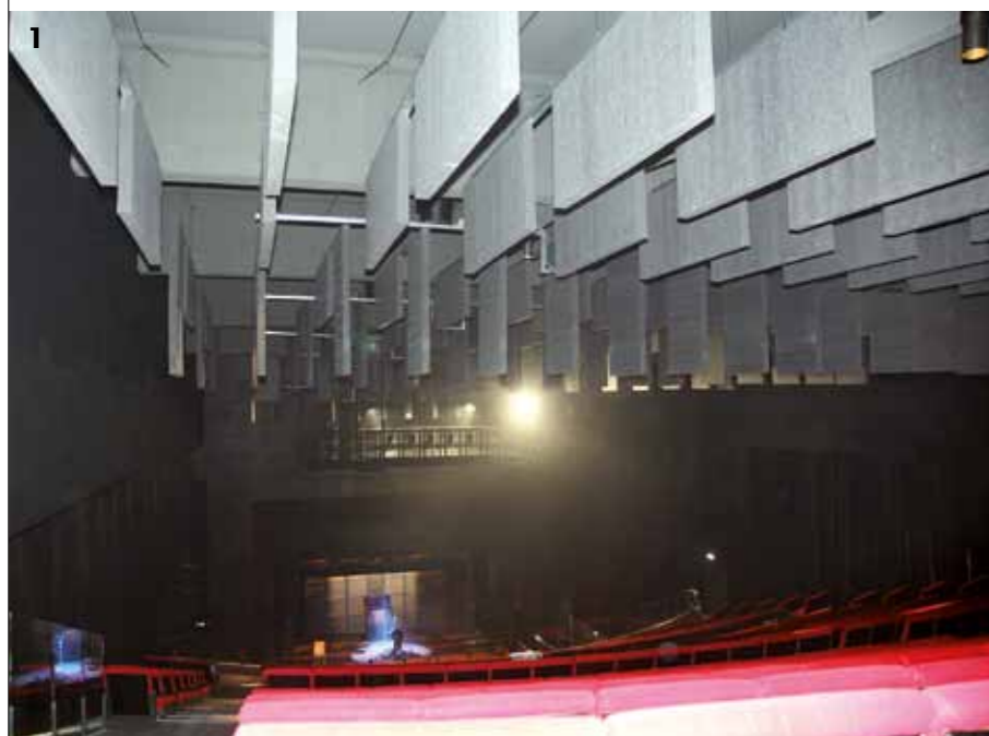
1_ Il trattamento acustico del soffitto.
